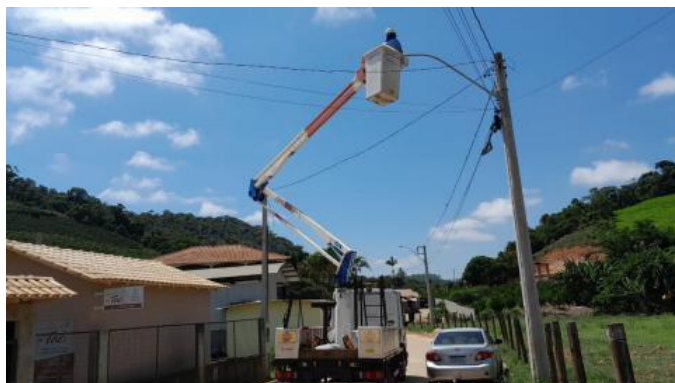
Instalação de luminárias LED - Iluminação Pública na Rua Gustavo Jastrow, Rio Possmoser, Dezembro.
